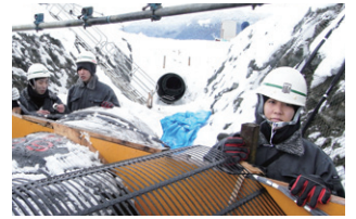
パイプラインの現場埋設実験（農水省）
