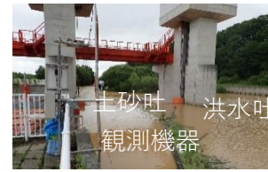
頭首工地点の機器設置状況
